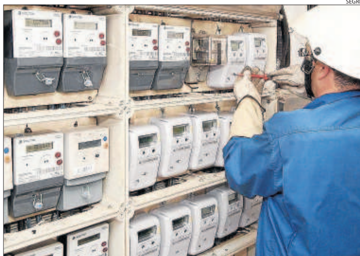
Imatge d'arxiu d'un operari instal·lant comptadors de la llum.
